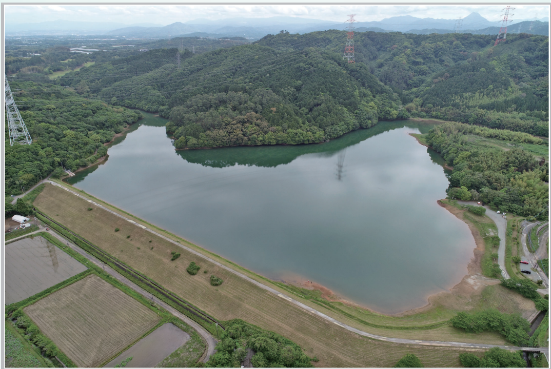
防災重点農業用ため池【熊本県宇城市萩尾ため池】
